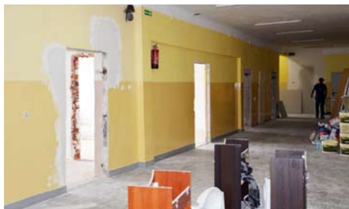
Na parterze szkoły trwa remont. We wrześniu przedszkole rozpocznie swoją działalność
