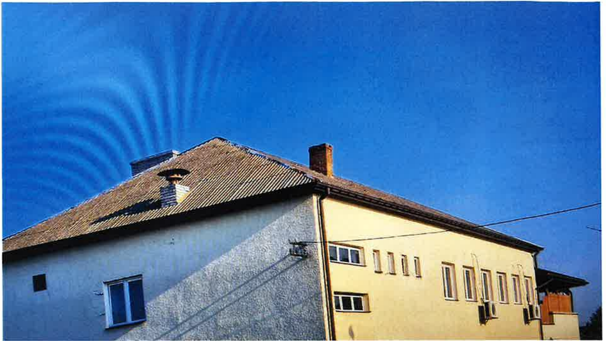
Foto. 2. Fragment budynku przed wymianą pokrycia dachowego (fot. W. Gowin)
